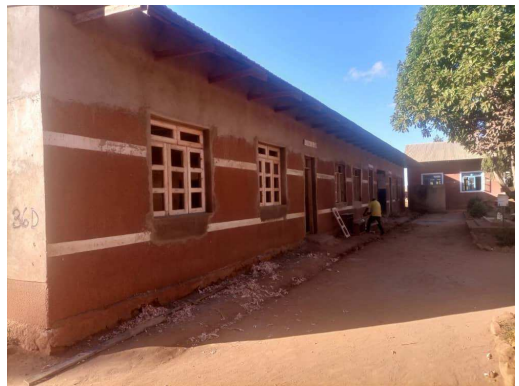
Renovierung der Grundschule in Igongolo
