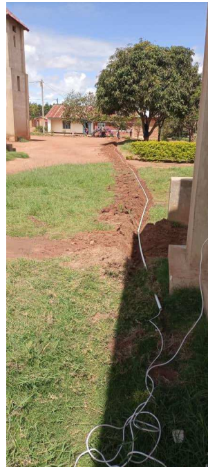
Verlegung der Informationskabel zwischen den Häusern
